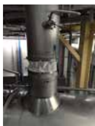
Rękawy elastyczne montowane na opaskę zaciskową
